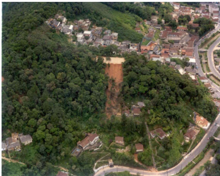
Figura 13b – Escorregamentos de aterro gerado por terraplenagem para a implantação de “caminho de futebol”, Bingen, Petrópolis, dezembro de 2001 (Foto cedida pela SOB/PMP).
