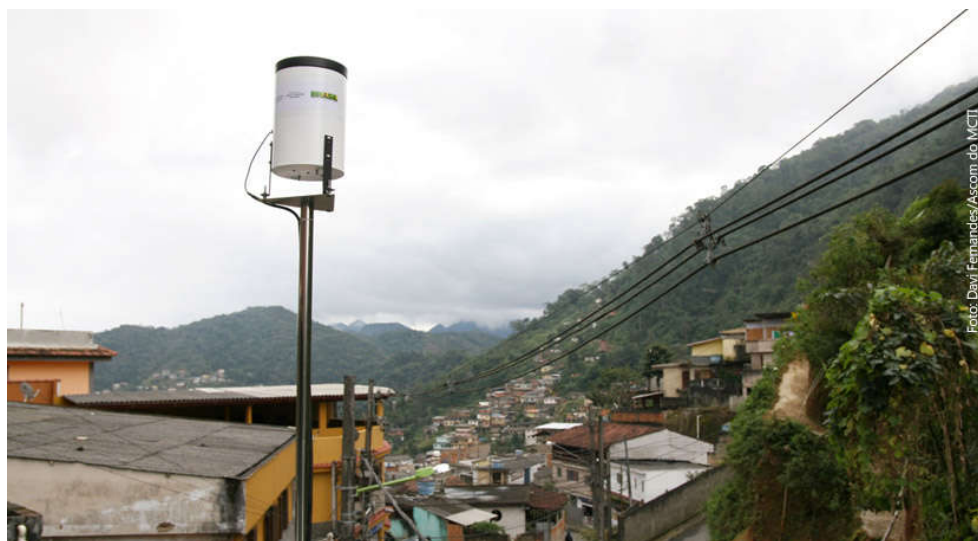
Figura 38 - Pluviômetro semiautomático instalado pelo CEMADEN/MCTI em Petrópolis,(junho/2013)
