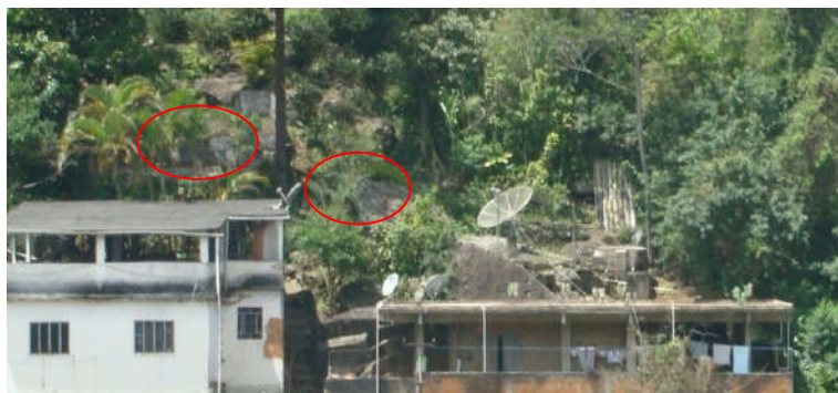
Figura 18 -Destacamento e queda de fragmentos de rocha na encosta a montante da Rua Timóteo Caldara, no bairro Itamarati (Veiga, 2013).
