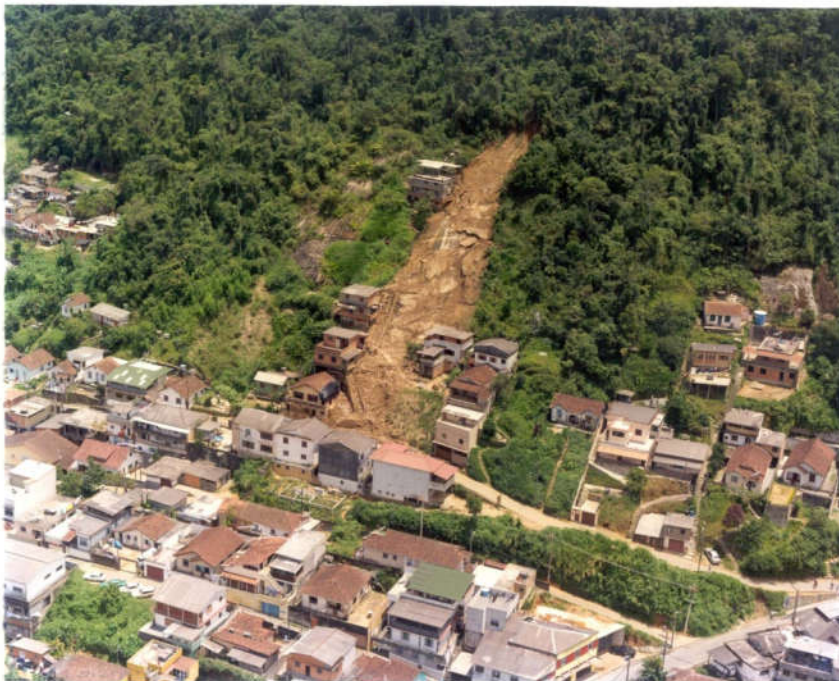
Figura 15c -Escorregamento de solo raso sobre rocha na encosta a montante da Rua Eugênio Werneck, Morin. (Oliveira, 2004).
