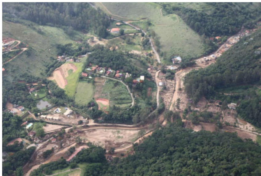
Figura 04 - Catástrofe provocada pela inundação dos rios Cuiabá e Santo Antônio em janeiro de 2011.
