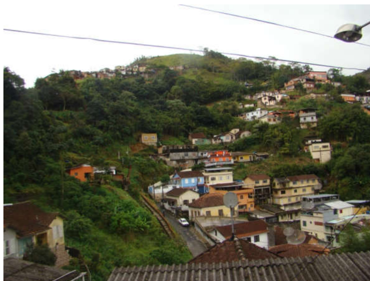
Figura 05- Vista de construções sobre terreno em movimento na Rua Casemiro de Abreu, Centro.
