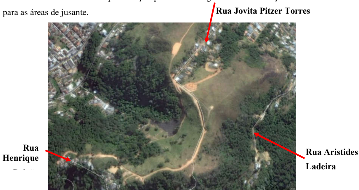
Figura 40 – abertura de uma via ilegal ligando a Rua Henrique Paixão à Rua Jovita Pitzer Torres (Google, 2016)
