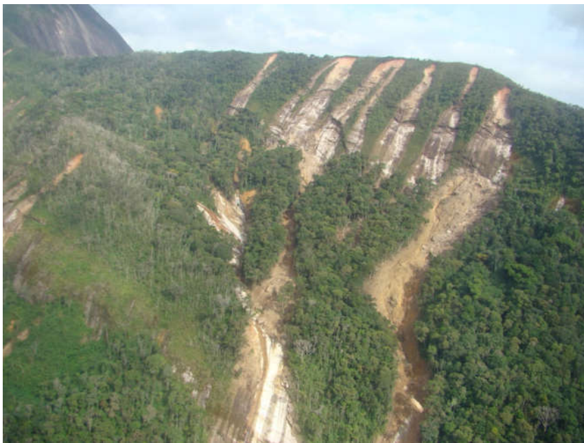
Figura 15b – Escorregamentos translacionais múltiplos em solo raso sobre rocha no Vale do Cuiabá, ocorridos na catástrofe de 2011.
