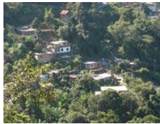
Foto 005 - Ocupação na encosta.
