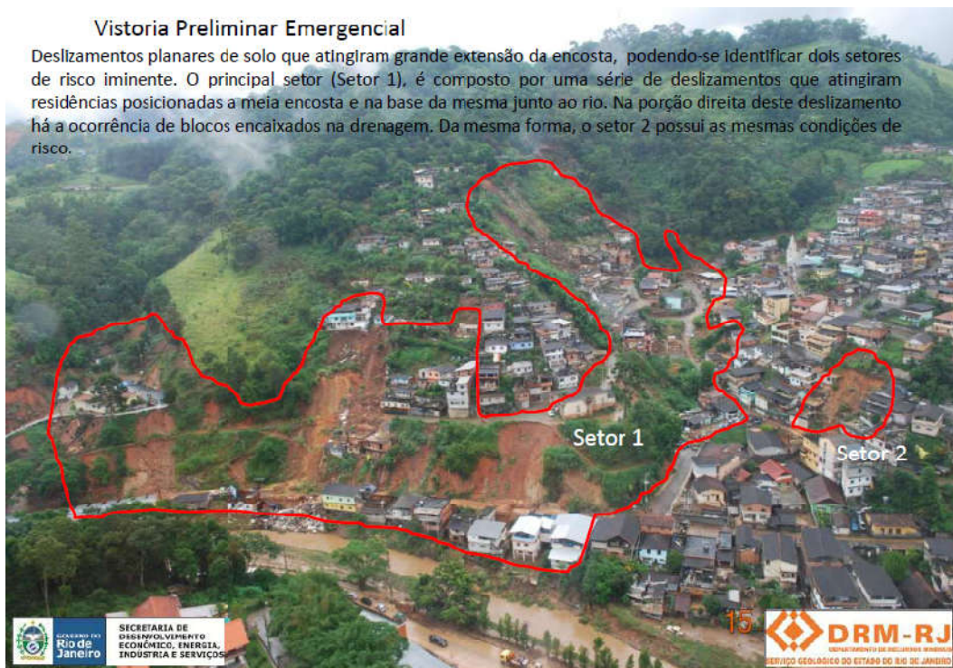
Figura 4.19 Foto aérea oblíqua para ilustração de Área de Risco Alto e Muito Alto (apud DRM-RJ, 2011)
