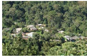
Foto 006 - Expansão em área sem infra-estrutura.
