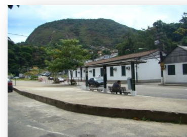
Ponto de ônibus existente na área de intervenção analisada.
